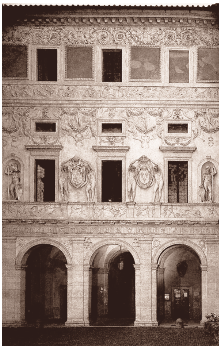
Cortile di Palazzo Spada
